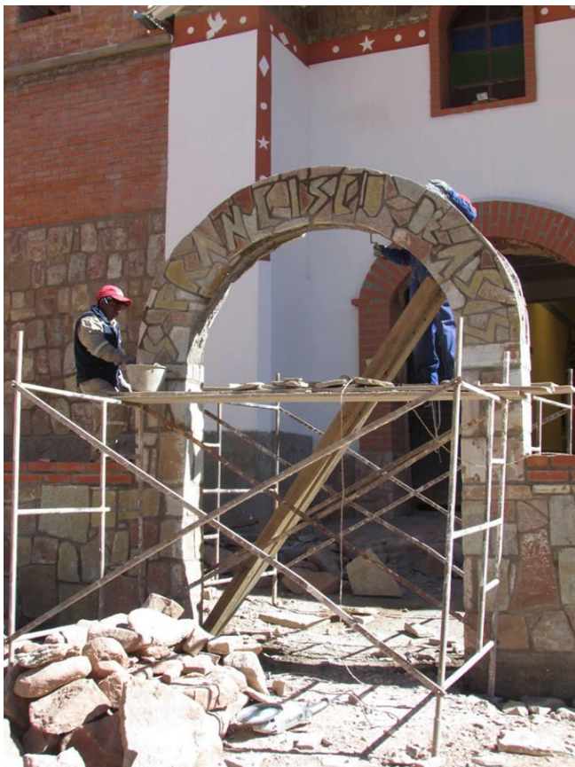
der neue Torbogen, innen Zement, aussen bunte Kalksteine
