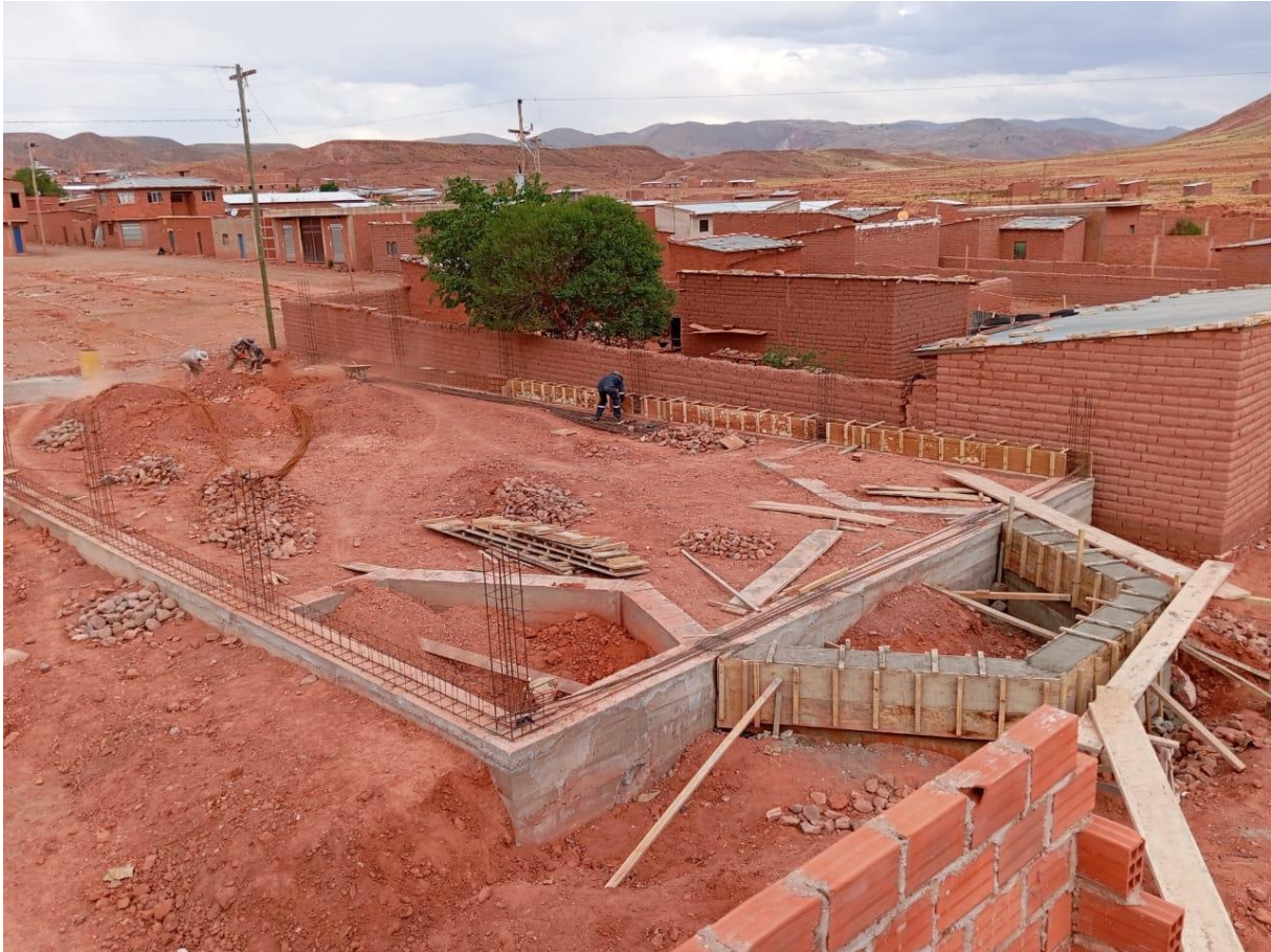
Der Bau der Kirche in Pampa Colorada ist gut gestartet
